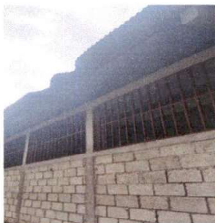
Foto1: SUSTITUCIÓN DE LAMINA, POR LAMINA TROQUELADA ALUZINC CALIBRE 26
