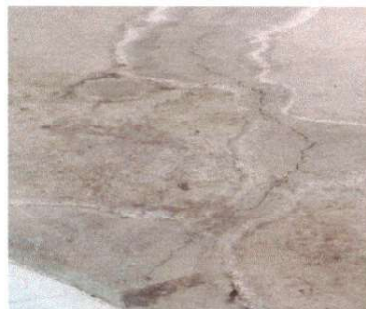
Foto 2: SUSTITUCIÓN DE PISO DE CEMENTO LIQUIDO
