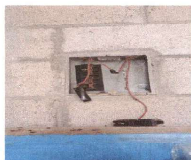
Foto 4: SUSTITUCION DE FLIPON
