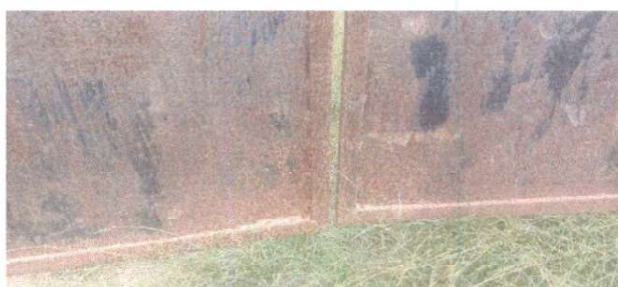
Foto 5: MANTENIMIENTO A PORTONES DE METAL
