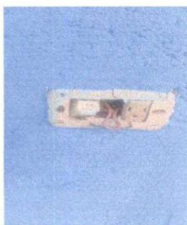
Foto 3: SUSTITUCION DE TOMACORRIENTES DOBLES
