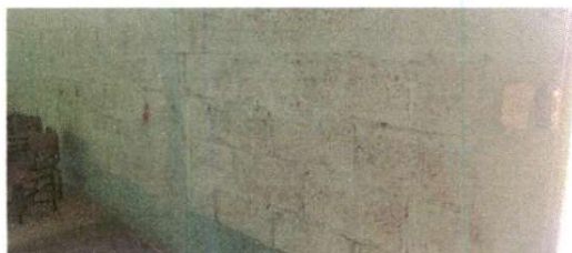
Foto 3: PINTURA EN MUROS EXTERIORES E INTERIORES
