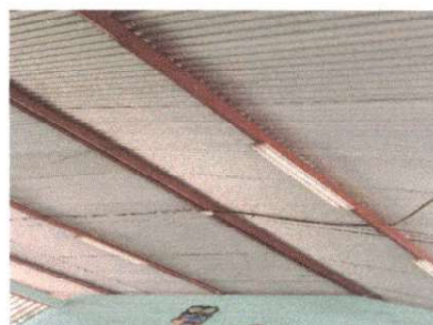
Foto 6: SUSTITUCION DE FOCOS AHORRADORES
