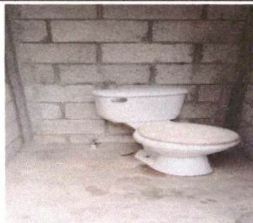
Foto 4: SUSTITUCION DE ACCESORIOS INODORO ( CONTRA LLAVE, TUBO DE ABASTO Y TANQUE
