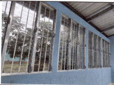
Foto: 3 Sustitución de ventanas por aluminio mas vidrio
