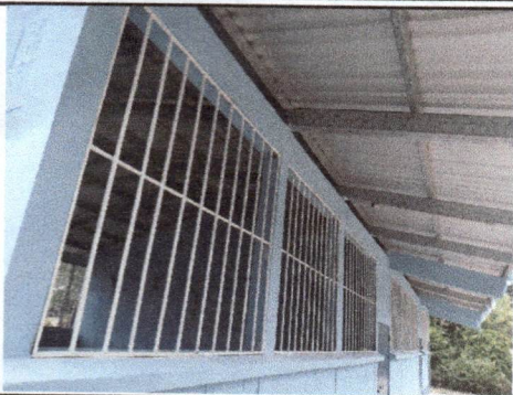
Foto 7: Mantenimiento a balcones de metal
