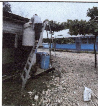
Foto 8: Sustitución de depósito de agua 1100 lt
