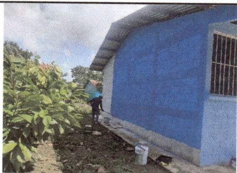
Foto: 5 Pintura en muros exteriores e interiores
