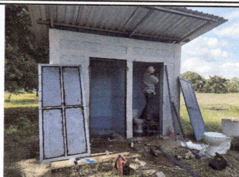
Foto: 2 Sustitución de puerta en servicios sanitarios
