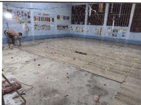
Foto: 4 Sustitución de piso cerámico
