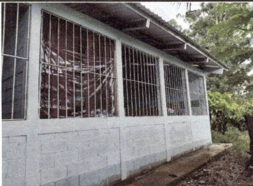
Foto 3: Sustitución de ventanas por aluminio mas vidrio
