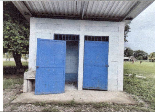
Foto 2: Sustitución de puerta en servicios sanitarios
