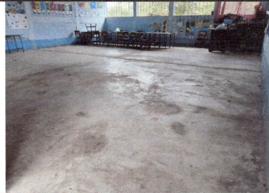
Foto 4: Sustitución de piso cerámico
