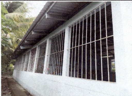
Foto 7: Mantenimiento a balcones de metal
