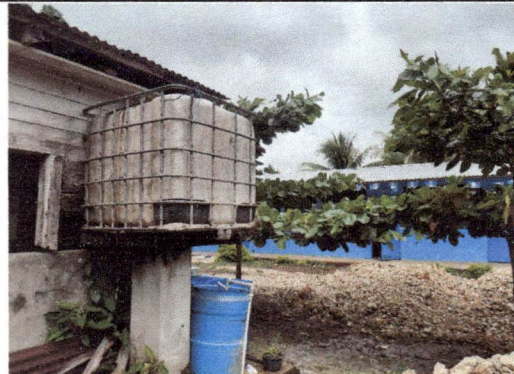
Foto 8: Sustitución de depósito de agua 1100 lt
