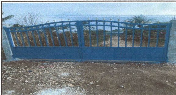
Foto 2: Sustitución de portón de metal
