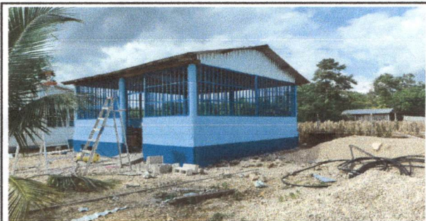
Foto 7: Sustrucción de ventanas de madera por metal
