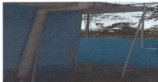
Foto 6: Sustitución de tubería línea principal
