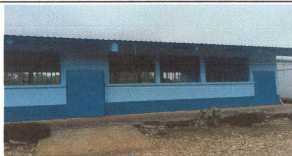
Foto 8: Pintura en muros exteriores e interiores
