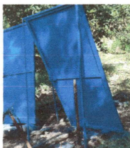
Foto 3: Sustitución de puerta
