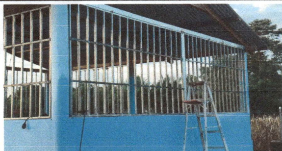
Foto 7: Sustrucción de ventanas de madera por metal
