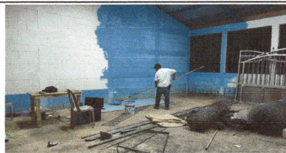
Foto 8: Pintura en muros exteriores e interiores
