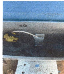
Foto 4: Sustitución de accesorios inodoro (contra llave, tubo de abasto y tanque)
