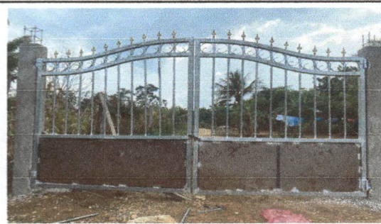
Foto 2: Sustitución de portón de metal
