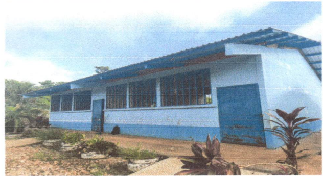
Foto 8: Pintura en muros exteriores e interiores
