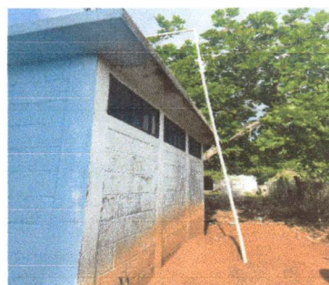
Foto 6: Sustitución de tubería línea principal
