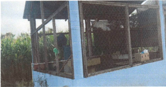
Foto 7: Sustrucción de ventanas de madera por metal
