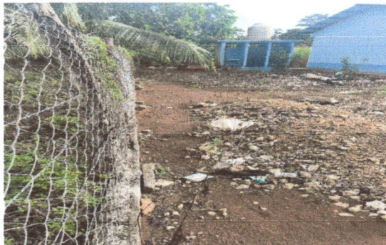
Foto 1: Reparación de muro perimetral de block con tubo hg y malla galvanizada, soleras intermedias y columnas.
