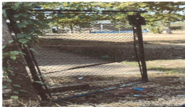
Foto 2: Sustitución de portón de metal
