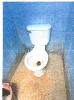
Foto: 4 Sustitución de accesorios inodoro (contra llave, tubo de abasto y tanque)
