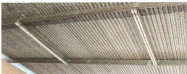
Foto 9: Sustitución de plafoneras
