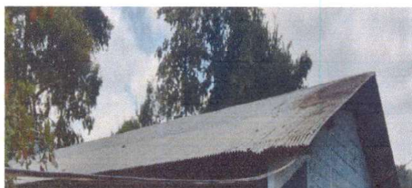
Foto 3: Sustrucción de elementos de fijación
