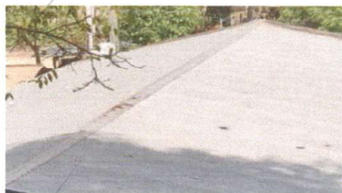
Foto 2: Sustrucción de capote de lámina para lámina troquelada
