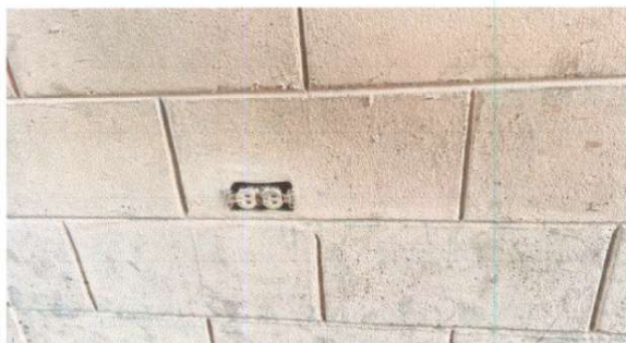
Foto 11: Sustitución de tomacorrientes dobles
