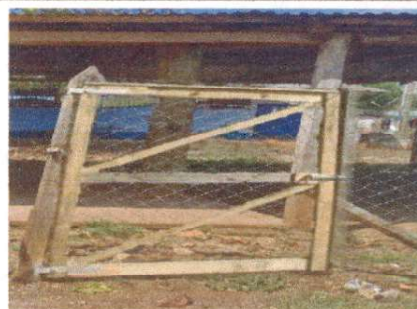
Foto 6: Sustrucción de Porton
