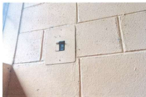
Foto 12: Sustitución de flipones
