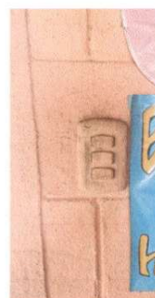
Foto 10: Sustitución interruptores dobles
