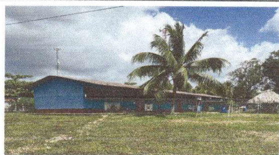
Foto 3: sustitución de elementos de fijación
