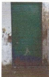
Foto 5: sustitución de puerta en servicios sanitarios
