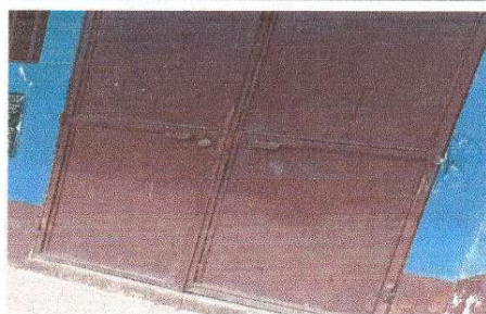
Foto 6: mantenimiento a estructura (lijado, cambio de tubo, cepillado, sujeciones, aplicación de pintura)
