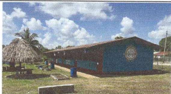
Foto 1: sustitución de lámina troquelada aluzinc calibre 26
