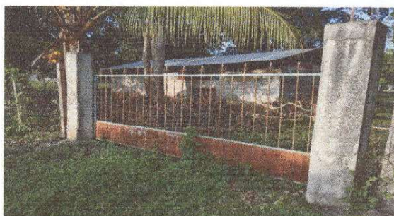
Foto2: fabricación e instalacion de porton de metal de ingreso
