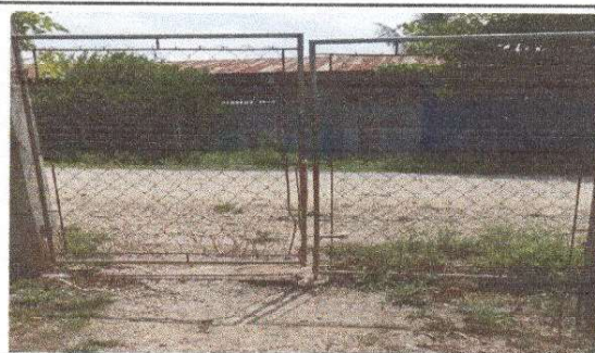
Foto 4: sustitución de portón de metal
