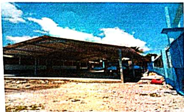
Foto1: Sustitución de Lámina por lámina troquelada de aluzinc calibre 26
