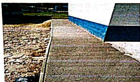
Foto 5: Reparación de banquetas de concreto
