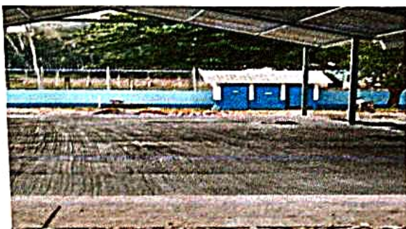
Foto 3: Sustitución de piso de torta de concreto
