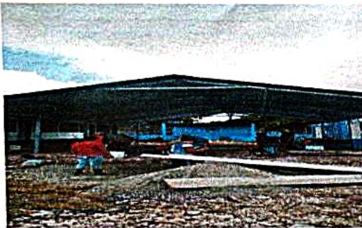
Foto 3: Sustitución de piso de torta de concreto
