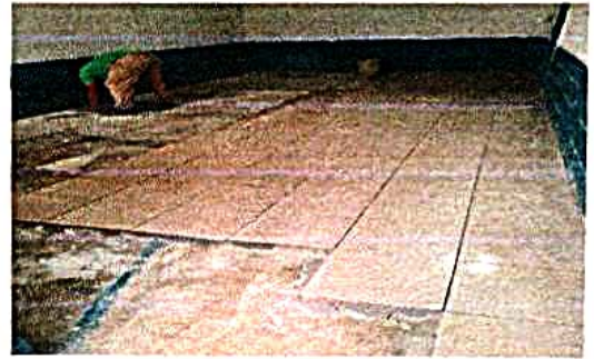
Foto 4: Sustitución de piso cerámico
