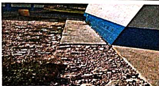
Foto 5: Reparación de banquetas de concreto
