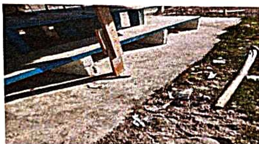
Foto 3: Sustrucción de piso de torta de concreto
