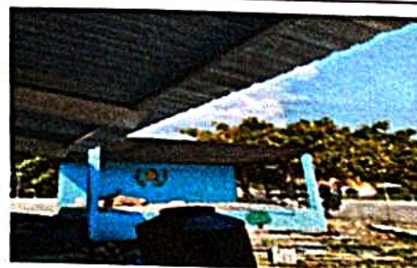
Foto 6: Sustrucción de Lámina por lámina troquelada de aluzinc calibre 26
