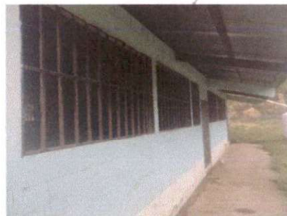
Foto 2: Mantenimiento a balcones de metal.
