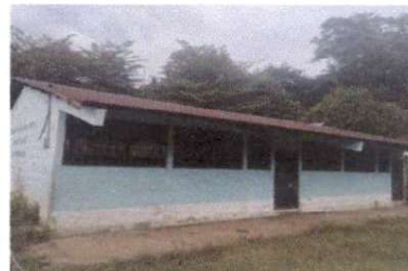
Foto 4: Pintura en muros exteriores e interiores.
