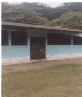
Foto 3: Mantenimiento a estructura de puertas de metal.
