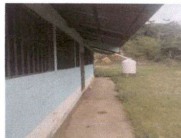
Foto 6: Sustrucción de canal pvc.
