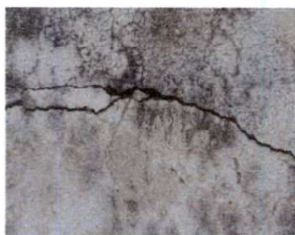
Foto 5: Sustrucción de piso de torta de concreto.
