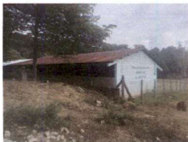
Foto1: Sustrucción de lámina, por lámina troquelada de aluzinc calibre 26.
