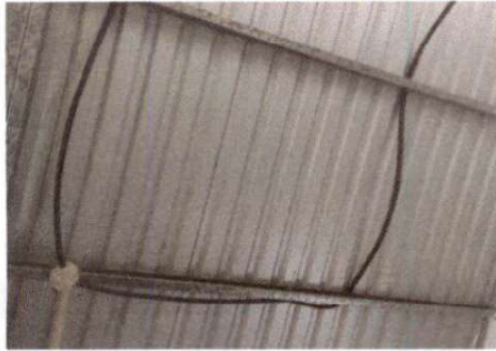
Foto7: Sustitución de ducto eléctrico más accesorios
