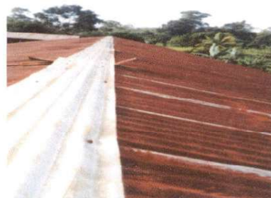
SUSTITUCIÓN DE ELEMENTOS DE FIJACIÓN
