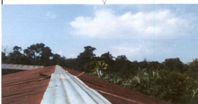
SUSTITUCIÓN DE CAPOTE DE LÁMINA PARA LÁMINA TROQUELADA
