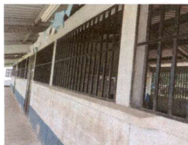
Foto 8: mantenimiento a balcones de metal
