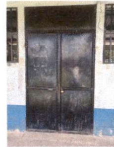
Foto 4: Mantenimiento a estructura de puertas
