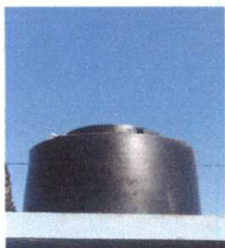
Foto 7: sustitucion de deposito de agua
