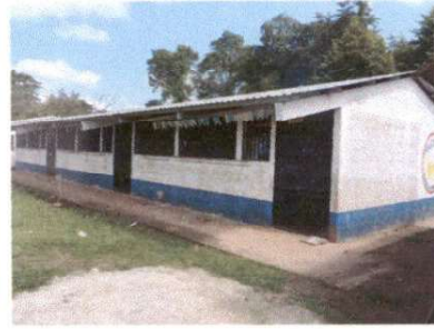
Foto 2: Pintura en muros externos e internos
