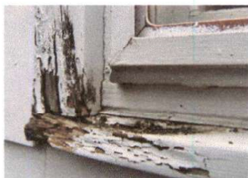
Foto 9: Sustitución de ventanas de madera por metal más vidrio
