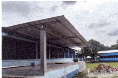
Foto1: SUSTITUCION DE LAMINA
