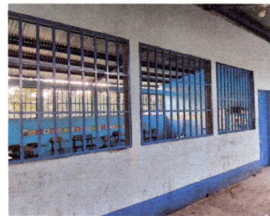
Foto 4: MANTENIMIENTO A BALCONES
