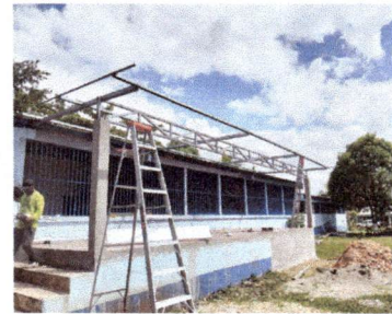
Foto 2: ESTRUCTURA DE SOPORTE DE MADERA POR METAL
