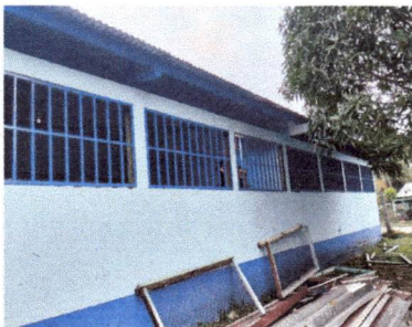
Foto 5: SUSTITUCION DE BALCONES DE METAL
