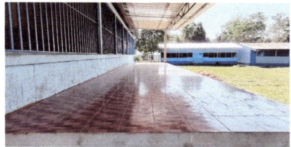
Foto 6: MEJORAMIENTO A PISO CERAMICO
