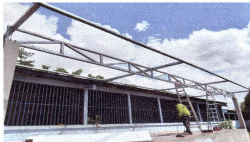
Foto 2: ESTRUCTURA DE SOPORTE DE MADERA POR METAL
