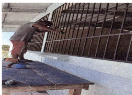
Foto 4: MANTENIMIENTO A BALCONES
