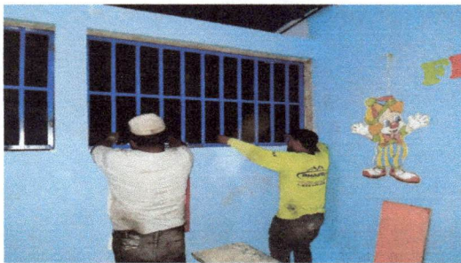
Foto 5: SUSTITUCION DE BALCONES DE METAL
