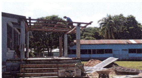
Foto1: SUSTITUCION DE LAMINA
