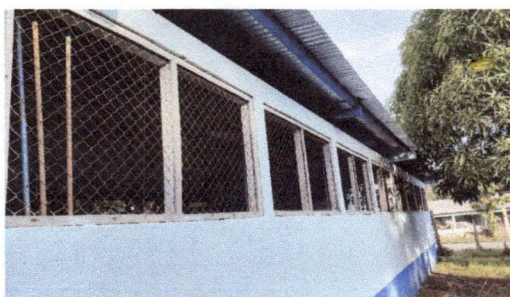
Foto 5: SUSTITUCION DE BALCONES DE METAL
