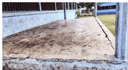
Foto 6: MEJORAMIENTO A PISO CERAMICO
