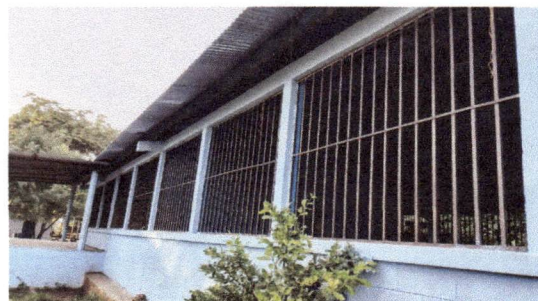
Foto 4: MANTENIMIENTO A BALCONES
