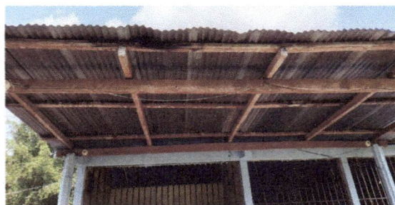
Foto 2: ESTRUCTURA DE SOPORTE DE MADERA POR METAL
