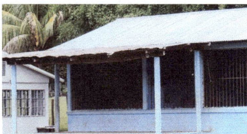
Foto1: SUSTITUCION DE LAMINA
