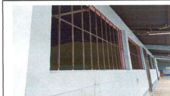
Foto 3: Mantenimiento a balcones de metal
