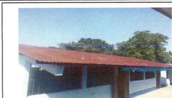
Foto1: Sustitución de lámina por lámina troquelada de aluzinc calibre 26
