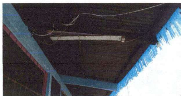
Foto 4: Sustitución de ducto electrico más accesorios
