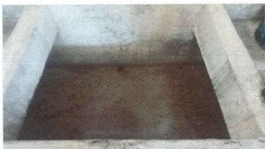
Foto 7: reparación de cisterna de concreto
