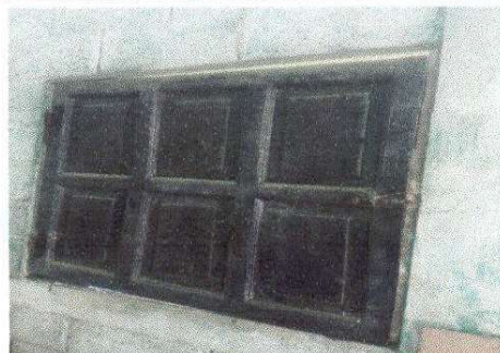
Foto 10: Sustitución de ventana de madera por metal mas vidrio
