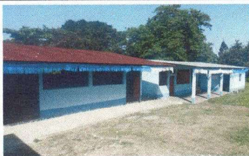
Foto 8: pintura en muros exteriores e interiores
