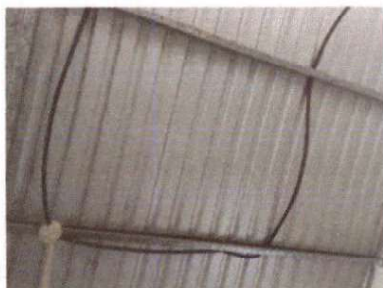
Foto7: Sustitucion de ducto electrico mas accesorios
