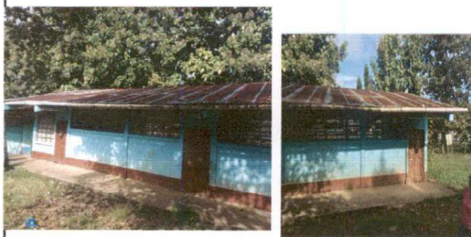
Foto1: Sustitución de lámina por lámina troquelada de aluzinc calibre 26
