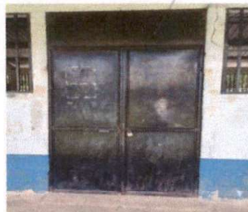
Foto 8: mantenimiento a puertas de metal
