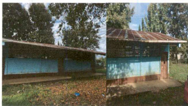
Foto 3: pintura en muros exteriores e interiores
