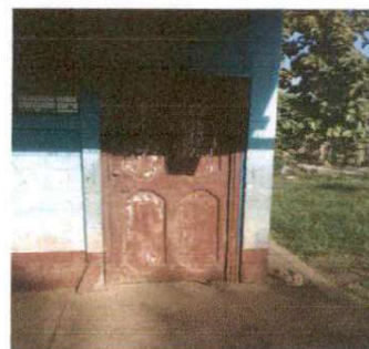
Foto 4: Sustitucion de puertas
