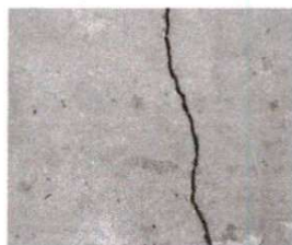
Foto 5: Reparación de piso de cemento líquido
