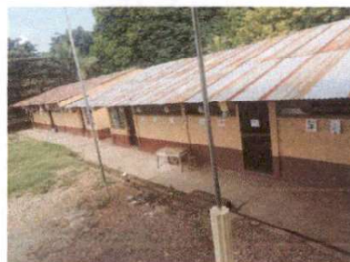
Foto 2: Pintura en muros externos e internos
