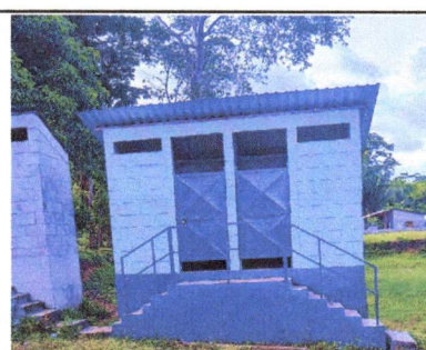
Foto 6: Mantenimiento a estructura
