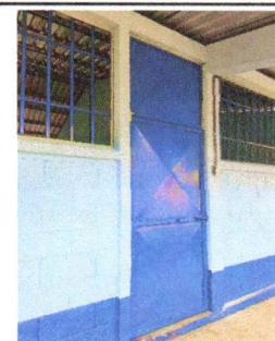
Foto 2: Sustitución de lámina, por lámina troquelada aluzinc calibre 26
