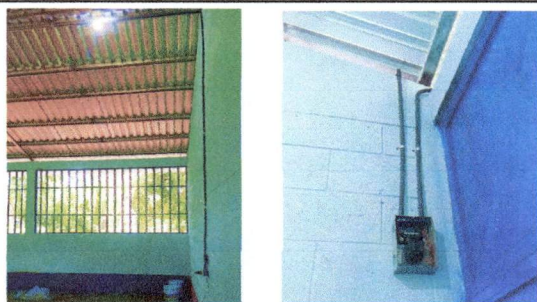
Foto: 5 Sustitución de ducto electrónico + accesorios
