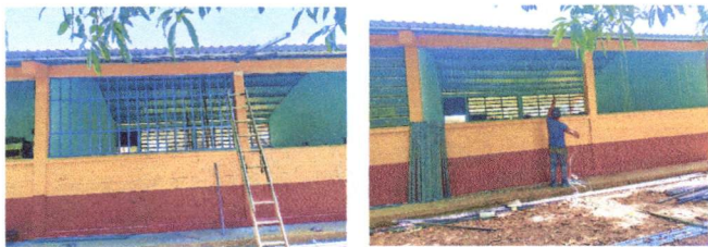
Foto 1: Sustitución de balcones de metal por metal
