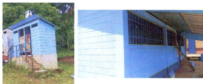
Foto: 6 Mantenimiento a estructura
