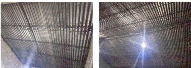
Foto: 3 Sustitución de estructura de soporte de metal, por metal
