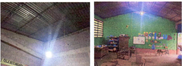
Foto: 5 Sustitución de ducto electrónico + accesorios
