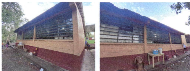
Foto 1: Sustitución de balcones de metal por metal
