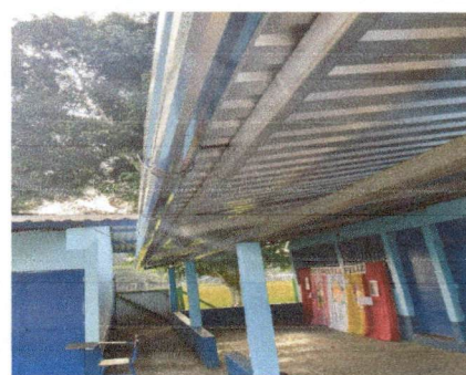
Foto 4: sustitucion Canal Pluvial de metal
