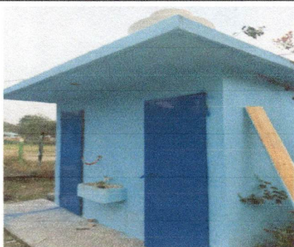
Foto1: Sustitucion de puertas
