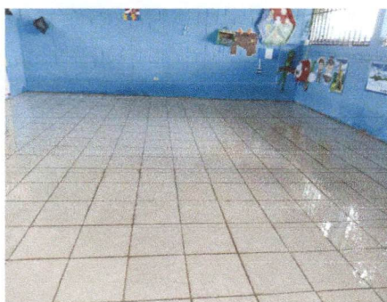
Foto 3: mejoramiento de piso de cemento liquido a piso ceramico
