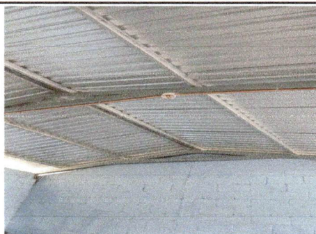
Foto 5: Sistema electrico ( sustitucion de focos ahorradores, plafoneras y ducto electrico mas accesorios)
