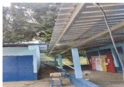
Foto 4: sustitucion Canal Pluvial de metal
