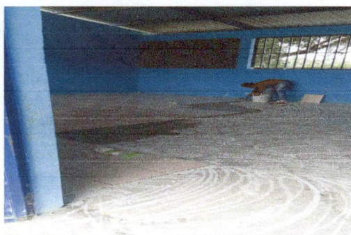
Foto 3: mejoramiento de piso de cemento liquido a piso ceramico
