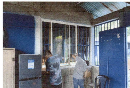
Foto 2: Mejoramiento de ventana por metal mas vidrio
