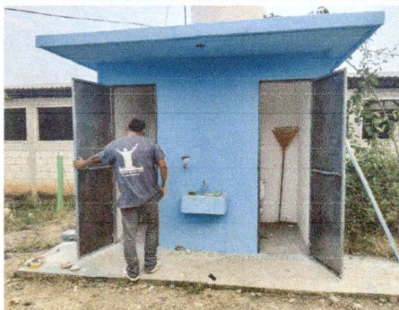
Foto1: Sustitucion de puertas
