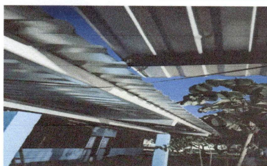
Foto 4: sustitucion Canal Pluvial de metal
