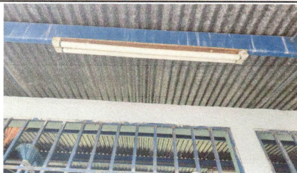
Foto 5: Sistema electrico (sustrucion de focos ahorradores, plafoneras y ducto electrico mas accesorios)
