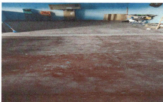
Foto 3: mejoramiento de piso de cemento liquido a piso ceramico
