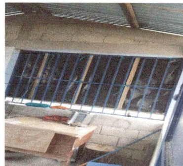
Foto 2: Mejoramiento de ventana por metal mas vidrio
