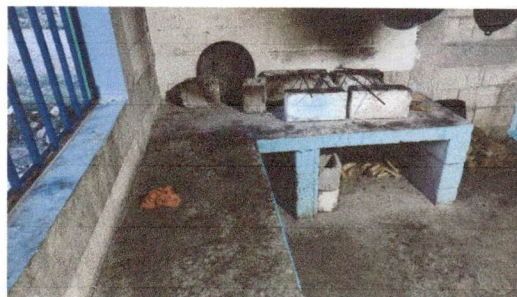
Foto 6: Sustrucion de estufa rural (completa) incluye chimenea y plancha de metal
