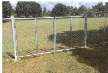
Foto 2: FABRICACION DE PORTON
