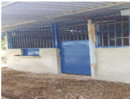
Foto1: FABRICACION DE PUERTA DE METAL EN COCINA
