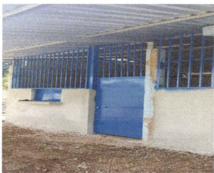
Foto 3: FABRICACION DE BALCONES EN COCINA
