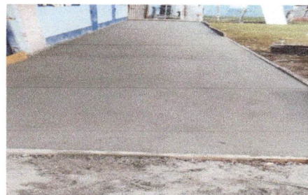
FOTO 6: PISO DE TORTA DE CONCRETO
