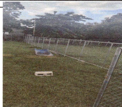
Foto 4: REPARACION DE TUBO HG Y MALLA GALVANIZADA
