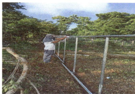
Foto 4: REPARACION DE TUBO HG Y MALLA GALVANIZADA
