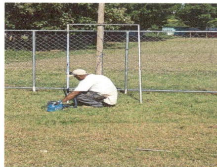
Foto 2: FABRICACION DE PORTON
