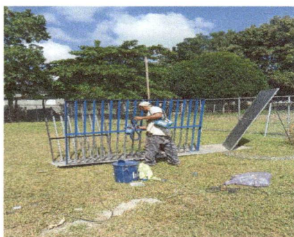
Foto 3: FABRICACION DE BALCONES EN COCINA
