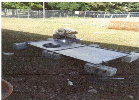
Foto1: FABRICACION DE PUERTA DE METAL EN COCINA
