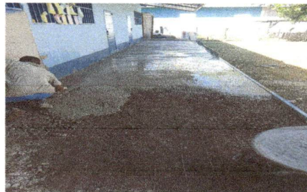
FOTO 6: PISO DE TORTA DE CONCRETO
