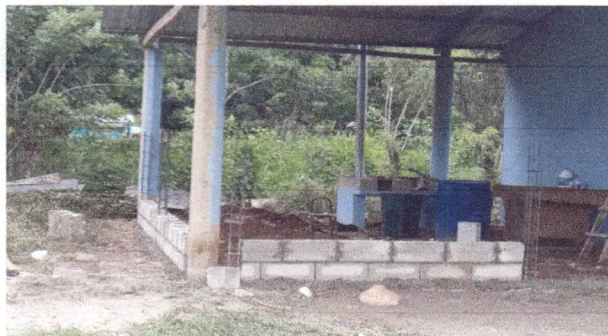
Foto1: FABRICACION DE PUERTA DE METAL EN COCINA
