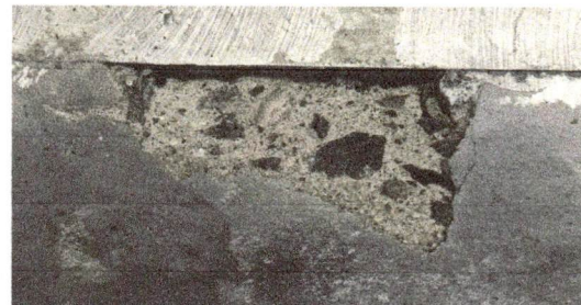
FOTO 6: PISO DE TORTA DE CONCRETO
