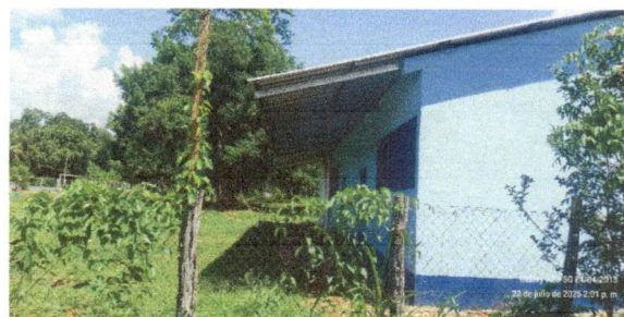
Foto 4: REPARACION DE TUBO HG Y MALLA GALVANIZADA
