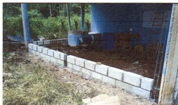
Foto 3: FABRICACION DE BALCONES EN COCINA
