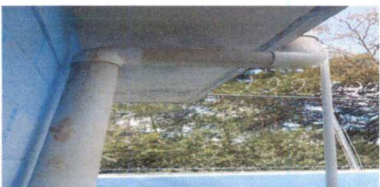
Foto 9: Sustrucción de tubería línea principal
