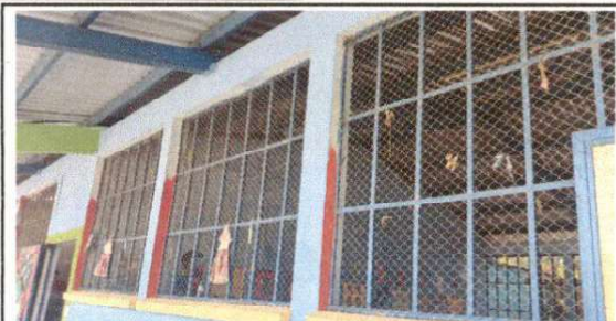
Foto 8: Mantenimiento de balcones de metal
