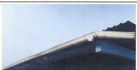
Foto 11: Sustrucción de canal de pvc
