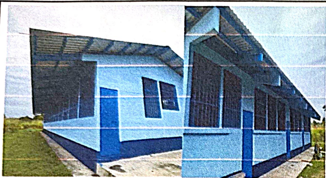
Foto1: Mantenimiento a balcon
