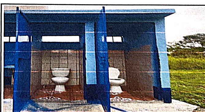
Foto 6: Colocación de azulejo en servicio de baños
