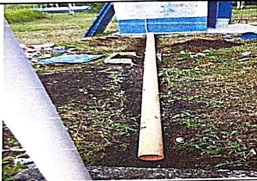
Foto 3: : Reparación red de drenaje
