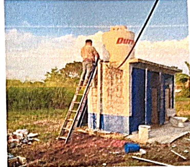
Foto 2: Reparación red de agua potable
