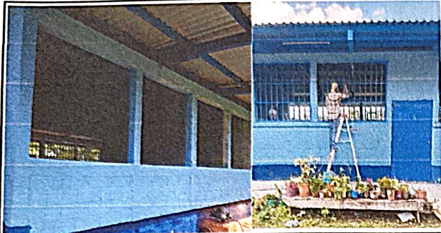
Foto 1: Mantenimiento a balcon
