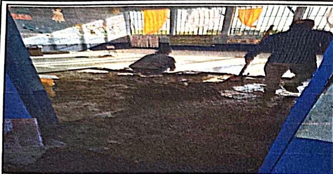
Foto1: Sustitución de Piso liso por Cerámico
