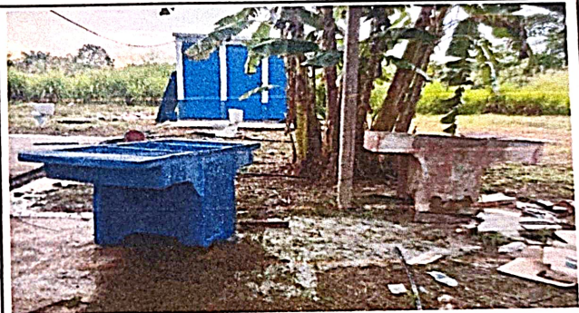
Foto 4: Sustitución de pila
