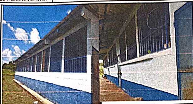
Foto 1: Mantenimiento a balcon
