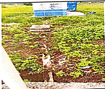
Foto 3: : Reparación red de drenaje
