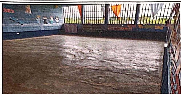
Foto1: Sustrucción de Piso liso por Cerámico
