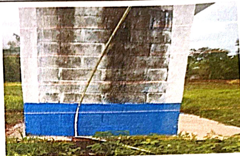
Foto 2: Reparación red de agua potable
