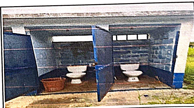
Foto 6: Colocación de azulejo en servicio de baños
