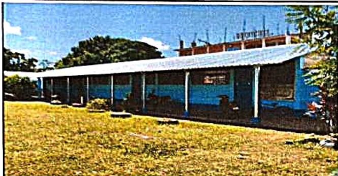
Foto1: Sustitución de lámina por lamina troquelada de aluzinc calibre 26
