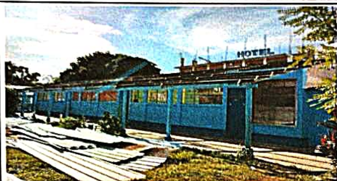
Foto1: Sustrución de lámina por lamina troquelada de aluzinc calibre 26
