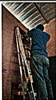
Foto 3: Sustrución de ducto electrico mas accesorios
