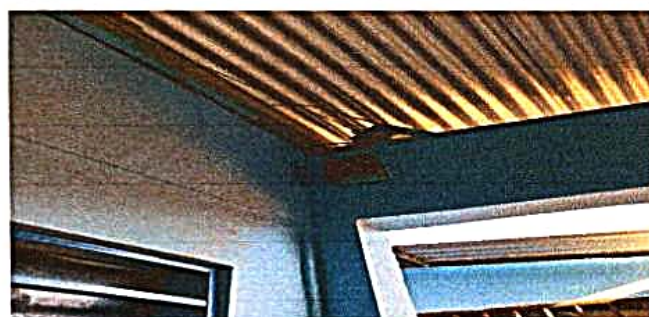
Foto 3: Sustitución de ducto electrico mas accesorios
