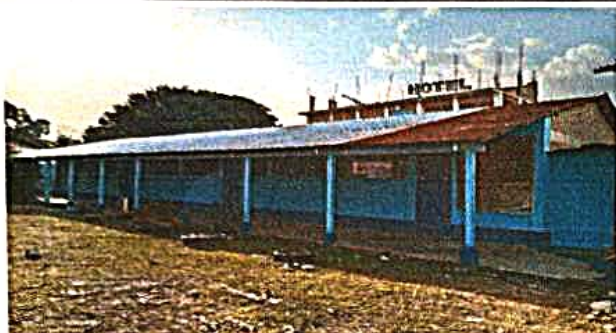
Foto1: Sustitución de lámina por lamina troquelada de aluzinc calibre 26
