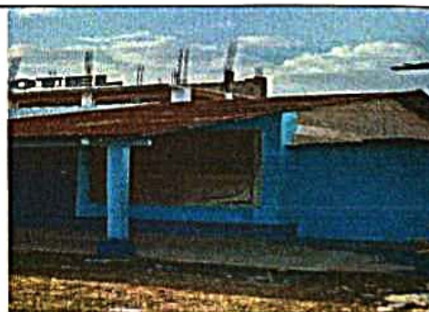
Foto 5: Sustitución de lámina por lamina troquelada de aluzinc calibre 26
