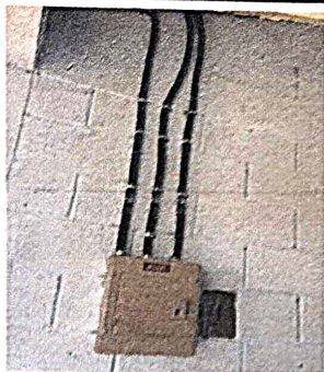
Foto 7: Sustitución de tablero de filipones
