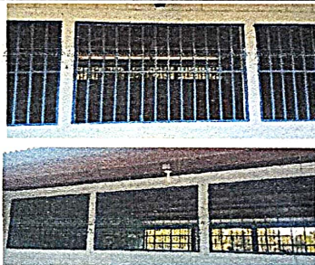
foto 6: Mantenimiento a balcones de metal
