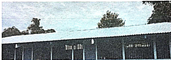
Foto 2 Sustitución de capote de lámina para lámina troquelada
