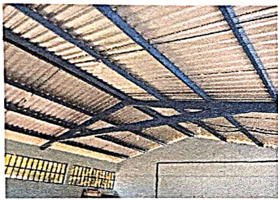
Foto: 3 Mantenimiento a estructura de soporte de metal
