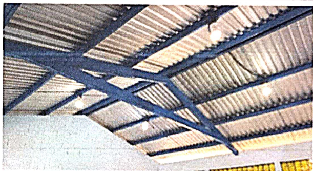
Foto 9: Instalación de unidades luz (incluye interruptor, ducto y cable eléctrico)
