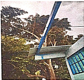
Foto 1: Sustrucción de lámina, por lámina troquelada aluzinc calibre 26
