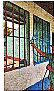
FOTO 4: Mantenimiento a estructura (lijado, cambio de tubo, cepillado, sujeciones, aplicación de pintura)
