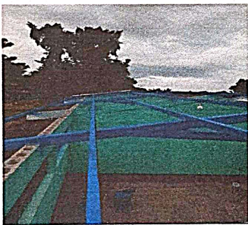
Foto 3: Mantenimiento a estructura de soporte de metal
