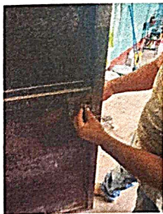
Foto 5: Sustrucción de chapa
