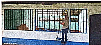
FOTO 4: Mantenimiento a estructura (lijado, cambio de tubo, cepillado, sujeciones, aplicación de pintura)
