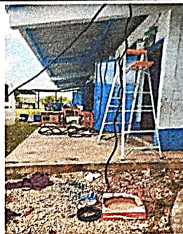
Foto 8: Reparación de cableado eléctrico
