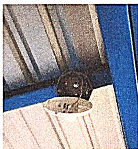
Foto 9: Instalación de unidades luz (incluye interruptor, ducto y cable eléctrico)
