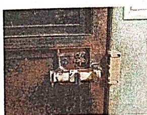
Foto 5: Sustitución de chapa
