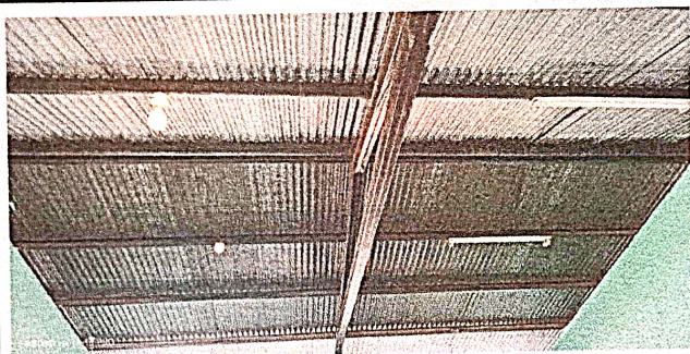
Foto: 3 Mantenimiento a estructura de soporte de metal
