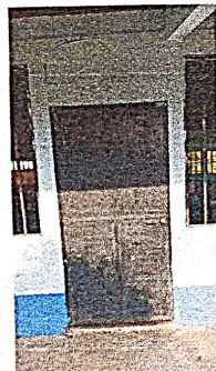
FOTO 4: Mantenimiento a estructura (lijado, cambio de tubo , cepillado, sujeciones, aplicación de pintura)
