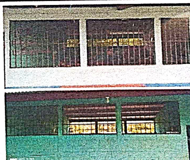
foto 6: Mantenimiento a balcones de metal
