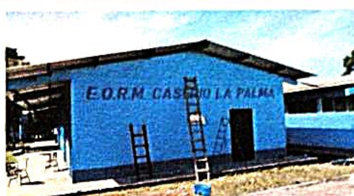
Foto 2: Pintura en muros exteriores
