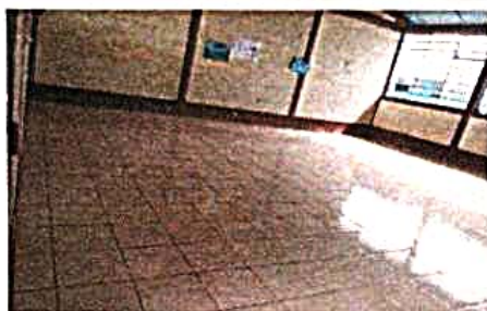
Foto 1: Sustrucción de piso cerámico
