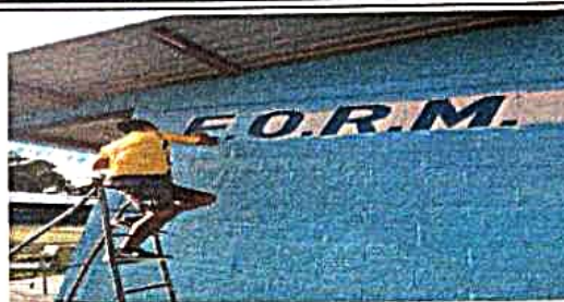
Foto 2: Pintura en muros exteriores
