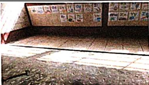
Foto 1: Sustrucción de piso cerámico
