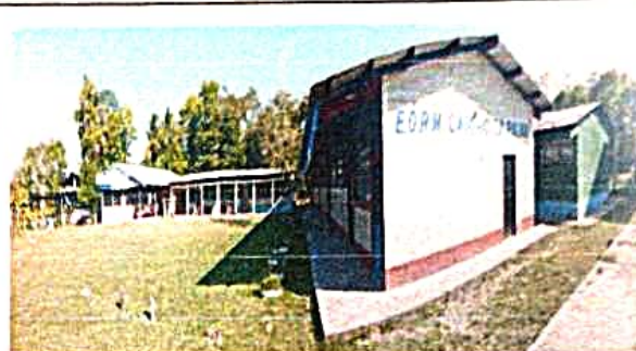
Foto 2: Pintura en muros exteriores
