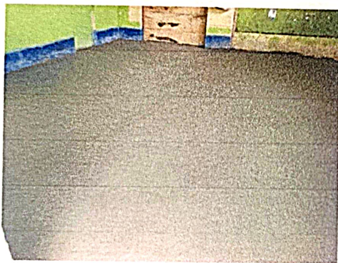
Foto 3 : Sustitucion de piso de torta de concreto
