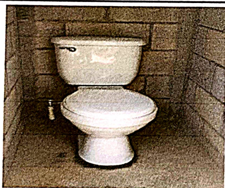
Foto 5: Sustitucion de inodoro
