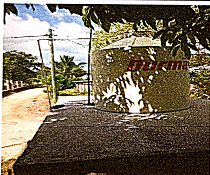
Foto 9: Sustitución de depósito de agua
