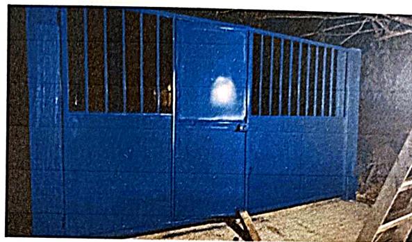
Foto 2: Sustitucion de porton de metal
