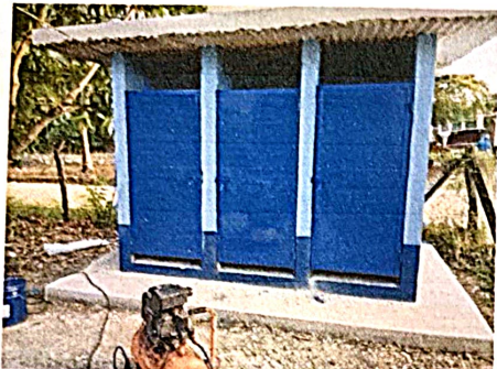
Foto1: Sustitucion de puertas
