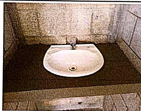
Foto 6: Sustitucion de lavamanos
