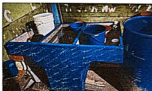
Foto 10: Sustitución de pila de cemento
