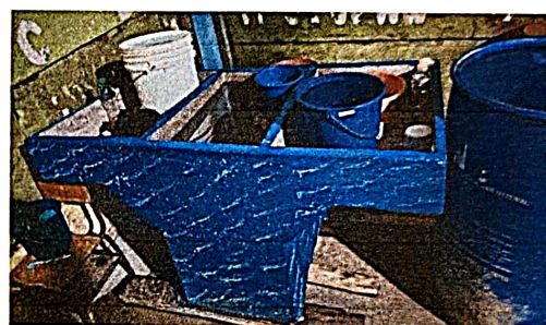
Foto 10: Sutitucion de pila de cemento
