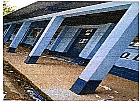
Foto 4: Pintura en muros exteriores
