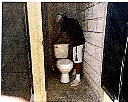
Foto 5: Sustitucion de inodoro
