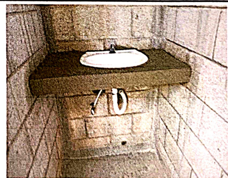
Foto 6: Sustitucion de lavamanos
