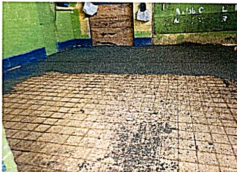
Foto 3 : Sustitucion de piso de torta de concreto
