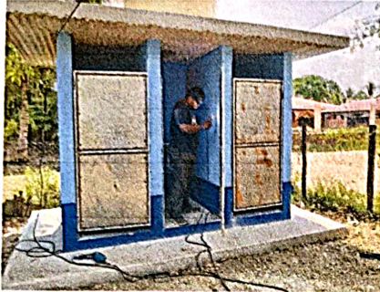
Foto1: Sustitucion de puertas
