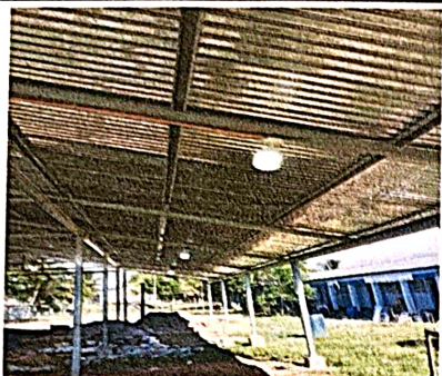
Foto7: Sustitucion de focos y plafoneras
