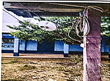
Foto7: Sustitucion de focos y plafoneras
