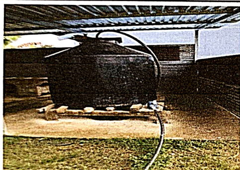
Foto 9: Sustitucion de depostio de agua
