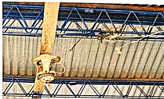
Foto 8: Reparacion de cableado y sustitucion de ducto electrico
