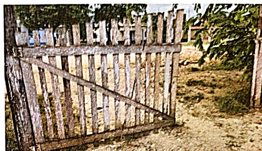
Foto 2: Sustitucion de porton de metal
