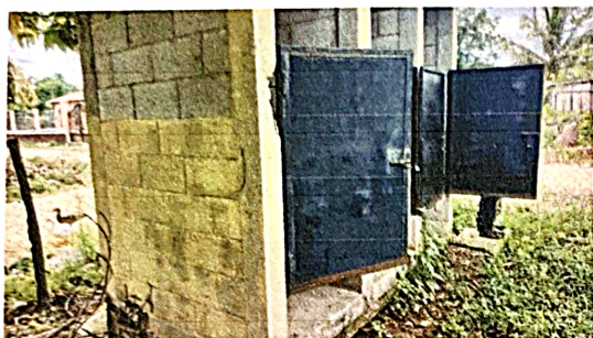
Foto 1: Sustitucion de puertas
