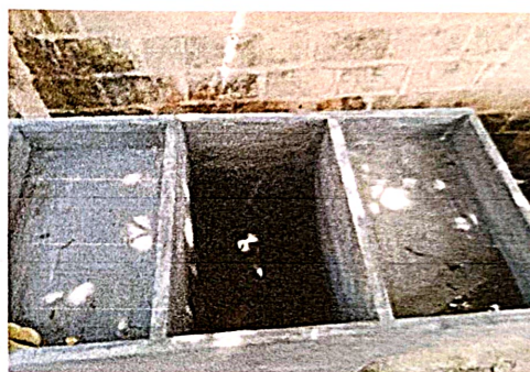
Foto 10: Sutitucion de pila de cemento
