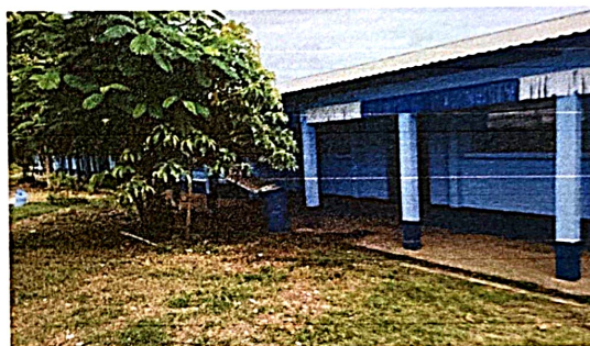
Foto 4: Pintura en muros exteriores
