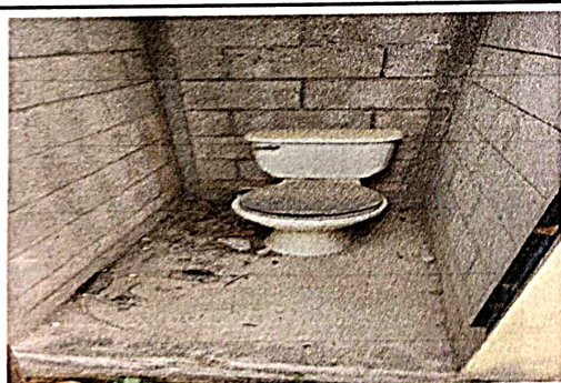
Foto 5: Sustitucion de inodoro
