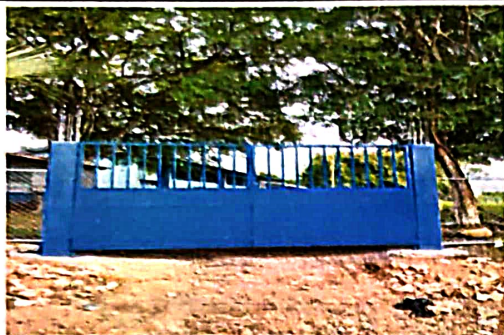
Foto1: Sustitucion de porton de metal
