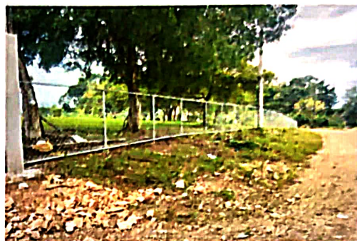
Foto 2: Reparacion de tubo hg y malla galvanizada
