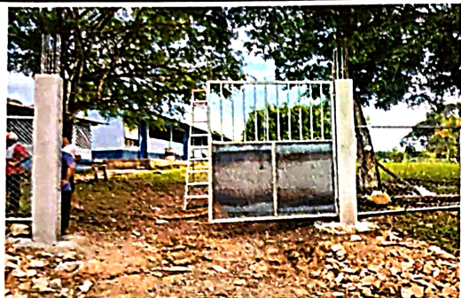
Foto1: Sustitucion de porton de metal
