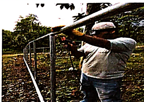
Foto 2: Reparacion de tubo hg y malla galvanizada
