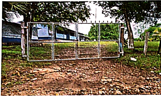
Foto1: Sustitucion de porton de metal
