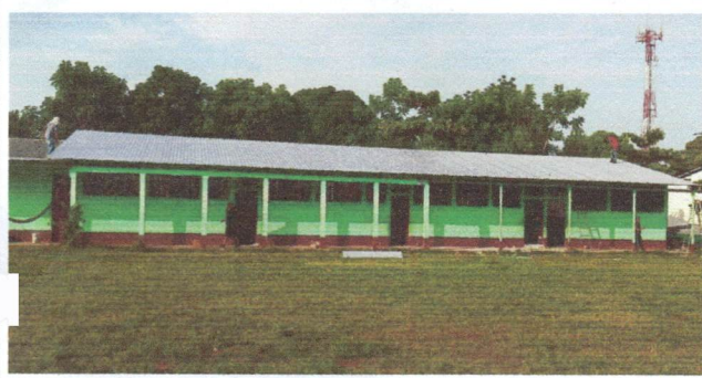
Foto 1: En la imagen se observa la instalación del techo.
