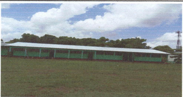
Foto 5: la instalación del techo fue finalizado en su totalidad.
