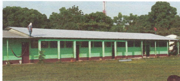
Foto 2: Se observa la finalización del techo
