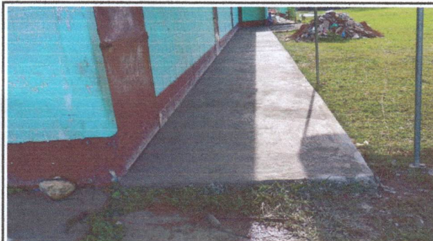
Foto 9: Este es el piso reparado y ya finalizado se observa en esta imagen.
